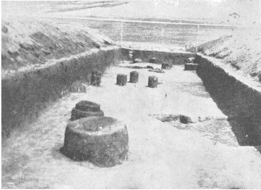
Fig. 3. — Vederea unui sector al săpăturii cu locul mormintelor de incinerare daco-romane și al bordeielor prefeudale.
